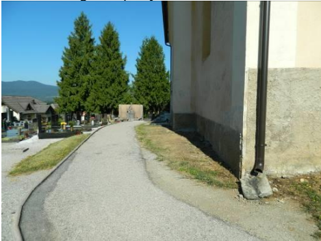
Slika 47: Segment poti južno od cerkve – meteorna voda odteka na teren
