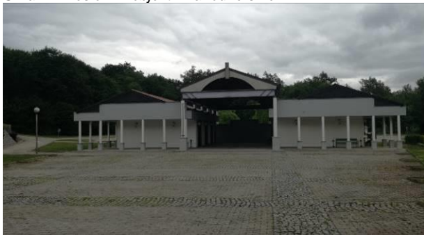
Slika 29: Pot pogreba poteka delno po javni poti med poslovilnim objektom in cerkvijo
