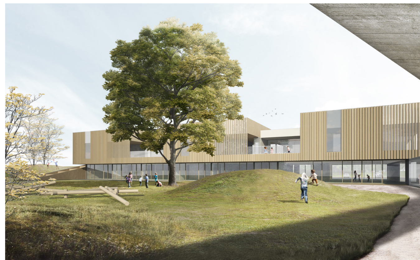
pogled z igrišča proti igralnicam: izhodišče zasnove predstavlja želja po ohranitvi obstoječe lipe, ki postane središče novega igrišča - atrija
